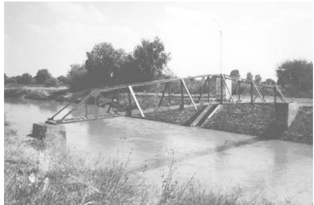
PUENTE DE AFORO
